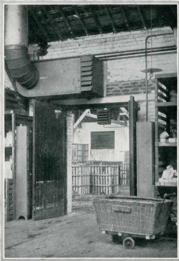
Fig. 6. — Pulsotherme disposé au-dessus d'une porte pour éviter les rentrées d'air froid.
