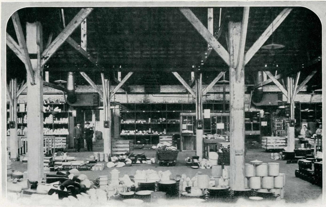
Fig. 8. — *Magasin d'une émaillerie chauffé par pulsothermes. Remarquer la disposition des trois appareils : Deux sont vus de côté, au fond et à droite de chacun des deux piliers du premier plan ; le troisième est vu de face, au milieu et au fond.*
